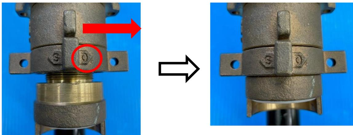
★東京都指定スリーブの縮み方向への移動が完全に終わるまでハンドルを○の方向へ回転させます。
