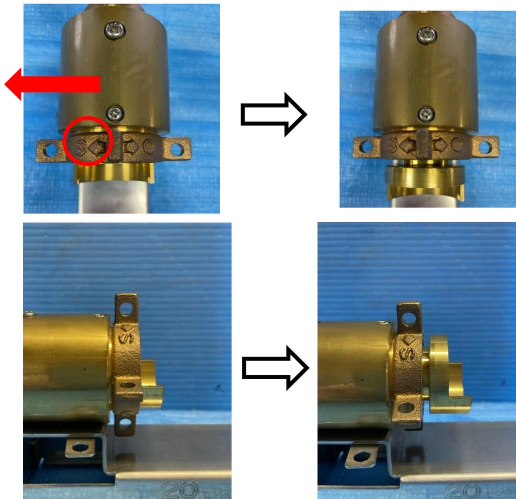
代用管もしくは水道メーターを取り外した状態にて、ハンドルをSの方向へ回転させるとスライド管が緩みます
